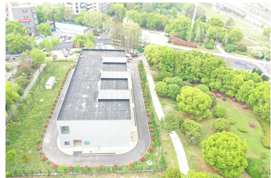
拟建所址南侧吴家山变电站
